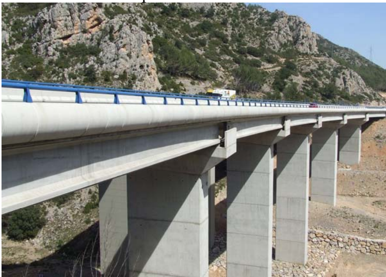
(foto: Puente Pretil)
